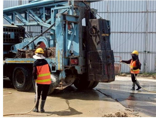
รูปที่ 6 คนงานฉีดล้างล้อรถบรรทุก
